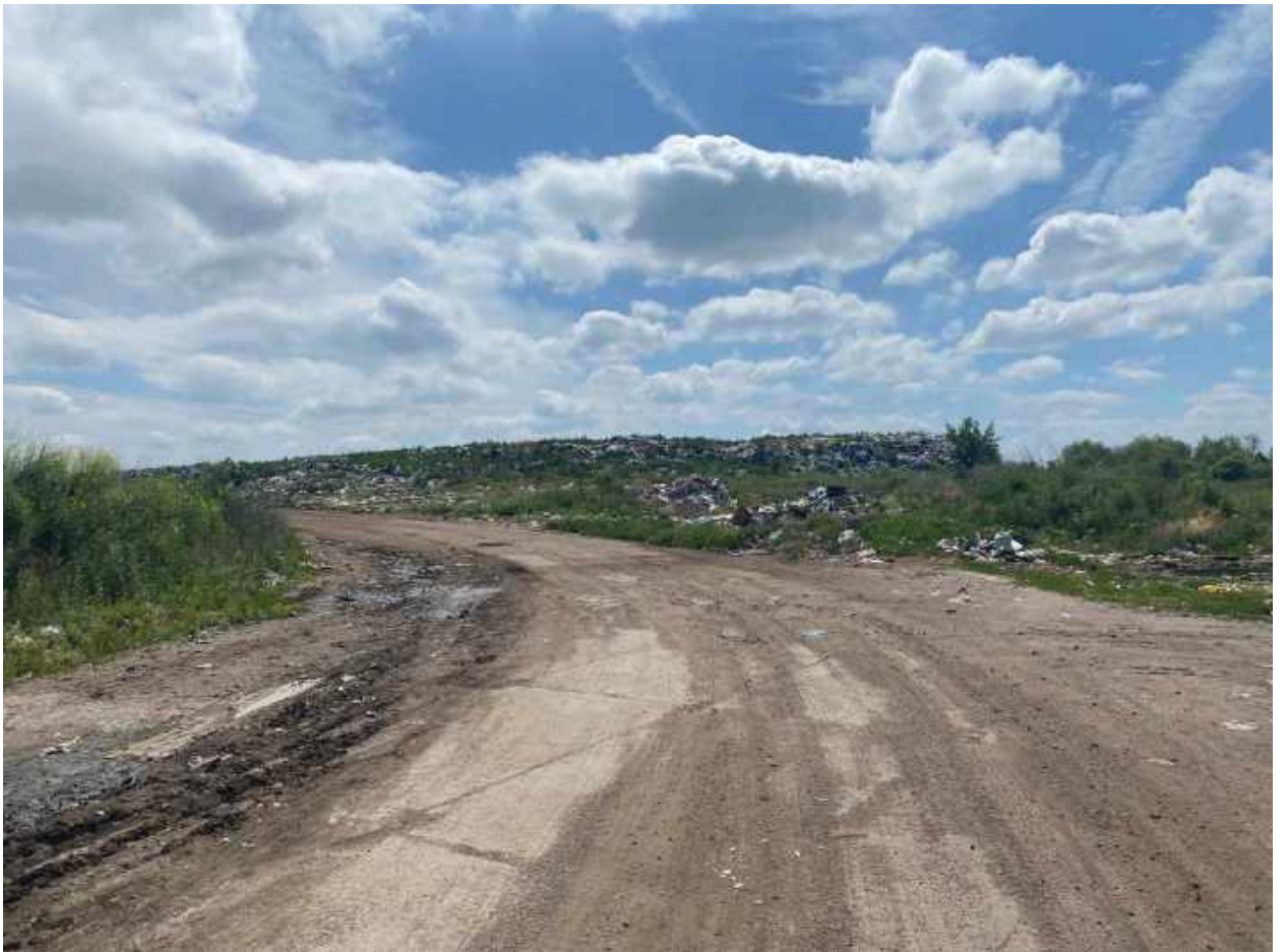
Рис. 4 – Існуючий стан полігону ТПВ м.Коростень (вид із заходу): дорога на I карту складування ТПВ
