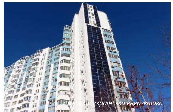
Сонячна станція у Дарницькому районі, місто Київ для забезпечення енергопостачання місць громадського користування та гарячого водопостачання. Джерело: Українська енергетика
